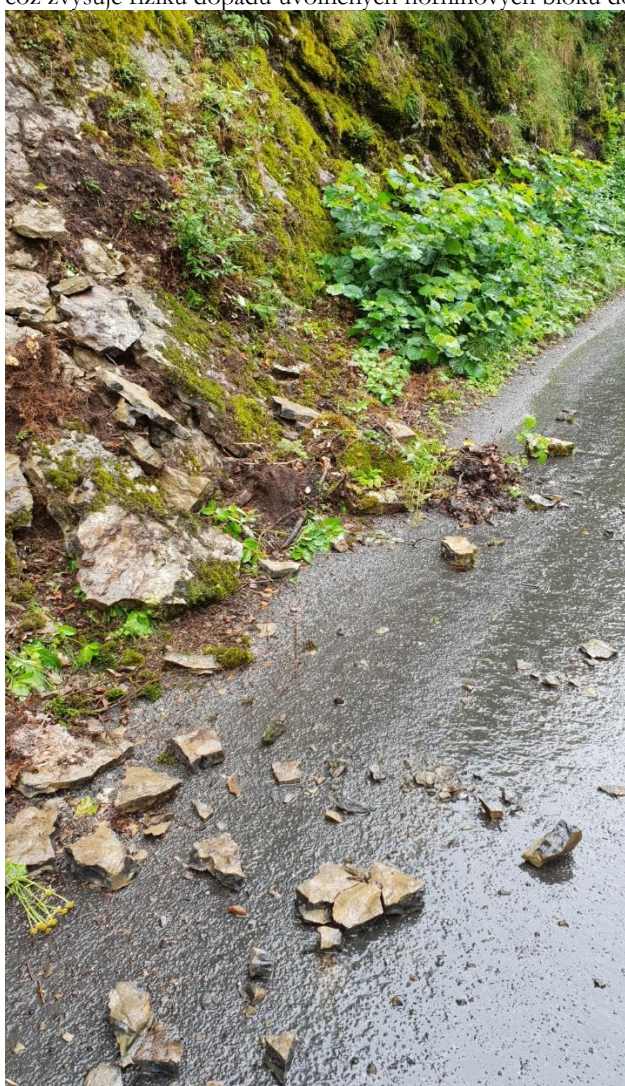
Foto 36 Drobné skalní říční ze svahu č. 7 jasně ukazuje povahu horninového materiálu i dopadovou vzdálenost. Foto L. Krejčí (2017).
