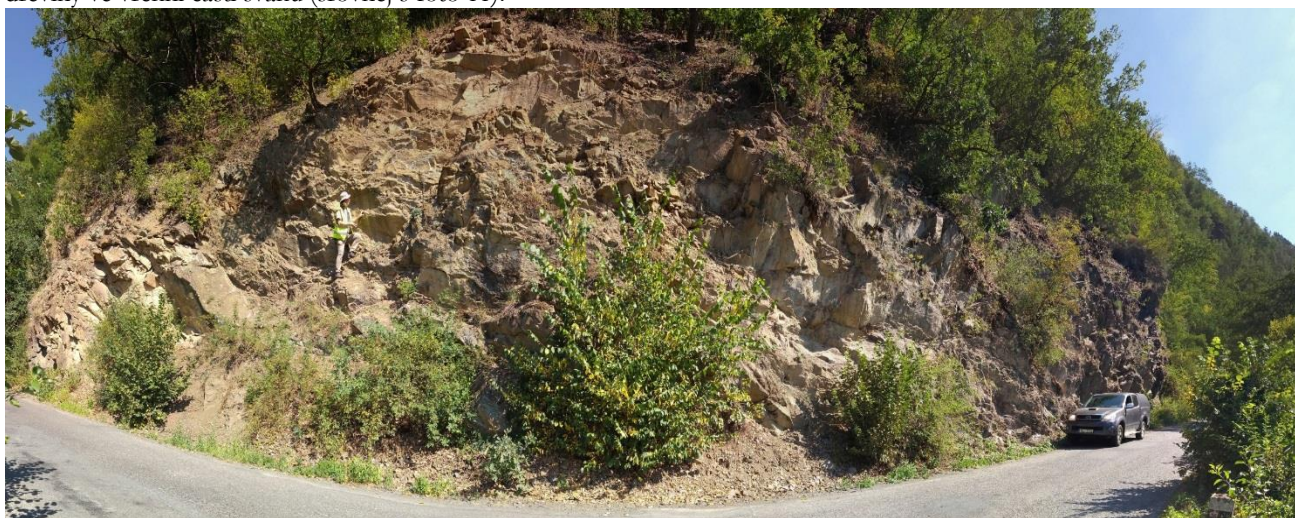
Foto 11 Jiný pohled na střední část skalního objektu č. 2. Hornina je místy značně zvětralá. Dobře patrné jsou také náletové dřeviny ve vrchní části svahu. Detail zvětralých partií viz foto 12 a 13.
