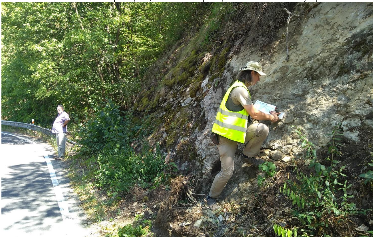
Foto 39 Boční pohled na rekognoskovaný skalní svah č. 7. Mezi patou svahu se silnicí II/116 je prostor pro umístění betonových svodidel, která by zabránila dopadům horninových bloků do prostoru vozovky.
