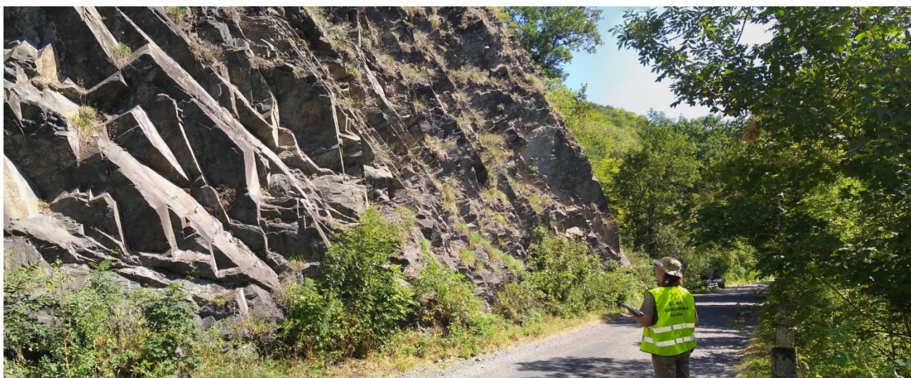
Foto 3 Nevýraznější pukliny ve svahu č. 1 jsou směru S–J (směr sklonu puklin 270/85^\circ ), dále směru SV–JZ (směr sklonu puklin 128/63^\circ až 133/45^\circ ) a směru V–Z (směr sklonu puklin 355/54^\circ ).
