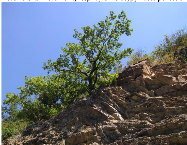
Foto 19 Horní partie skalního svahu č. 3 jsou porostlé poměrně hustou vegetací, kterou bude nutné při sanaci odstranit.
