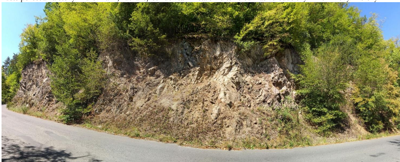
Foto 29 Stav skalního masivu č. 5 v jeho nejsevernější části. Skalní masiv je lokálně porostlý náletovými dřevinami – zejména ve své pravé (nejsevernější části) a nacházejí se v něm viditelně od masivu oddělené horninové bloky (viz foto 30).
