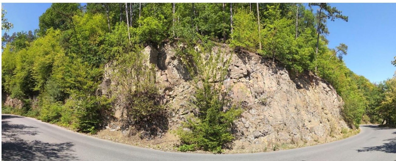
Foto 25 V této části skalního svahu č. 5 je porost náletových dřevin pouze lokální. Stejně jako v předchozích případech i zde však byly nalezeny rozvolněné partie svahu, nutné k odtěžení.
