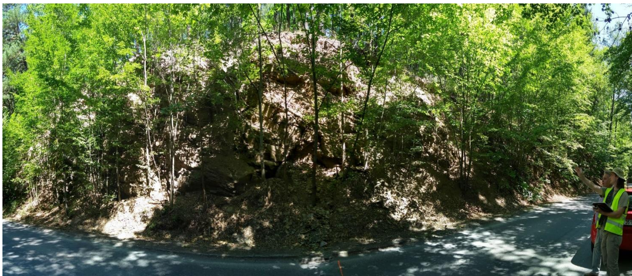
Foto 31 Skalní svah č. 6 je porostlý v celé své šíři náletovými dřevinami. Ty bude nutné plošně odstranit. Patrné jsou také osypy vytvářející se při patě svahu.
