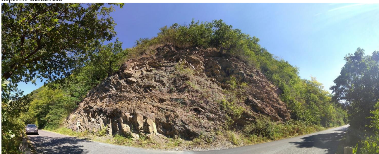
Foto 15 Západní část posuzovaného skalního objektu č. 3. Svah je zde porostlý vegetací pouze sporadicky, nicméně zde byly zjištěny rozvolněné partie, které bude nutné během sanace odstranit (detail těchto částí viz foto 16).
