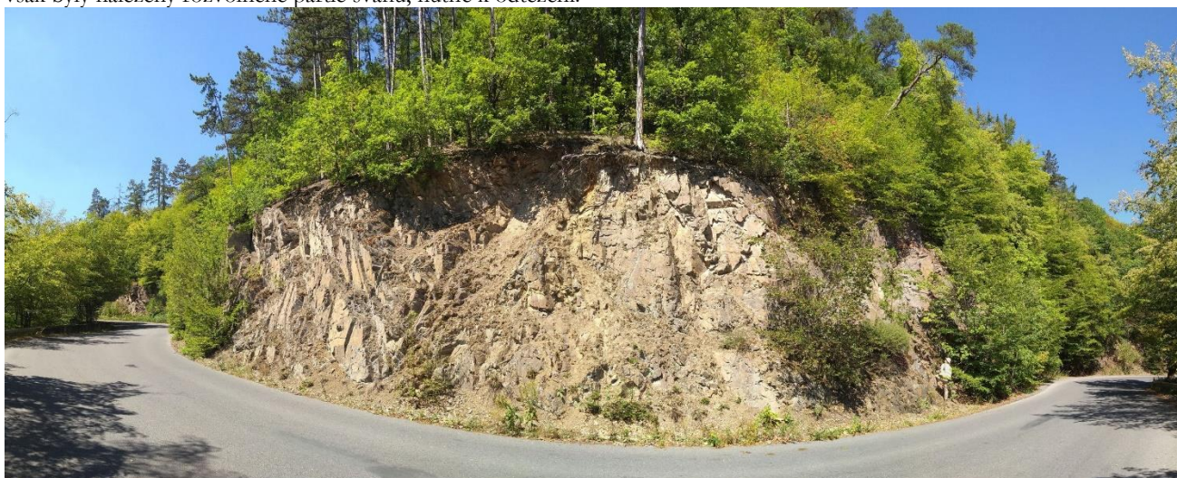
Foto 26 Další část skalního svahu č. 5 ve směru na Roztoky. Zde je skalní svah porostlý náletovými dřevinami jen v omezené míře. I zde však byly nalezeny viditelně od masivu oddělené bloky nutné k odtěžení.
